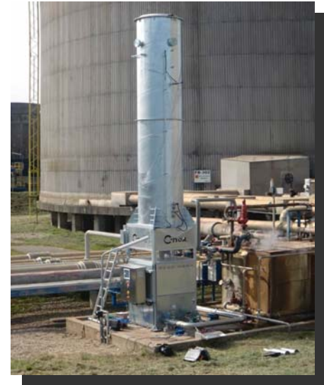
Betriebsfackel Typ HTV 1,0, Ammoniakanlage 1.100 Bm 3 /h, Brunsbüttel / Deutschland
