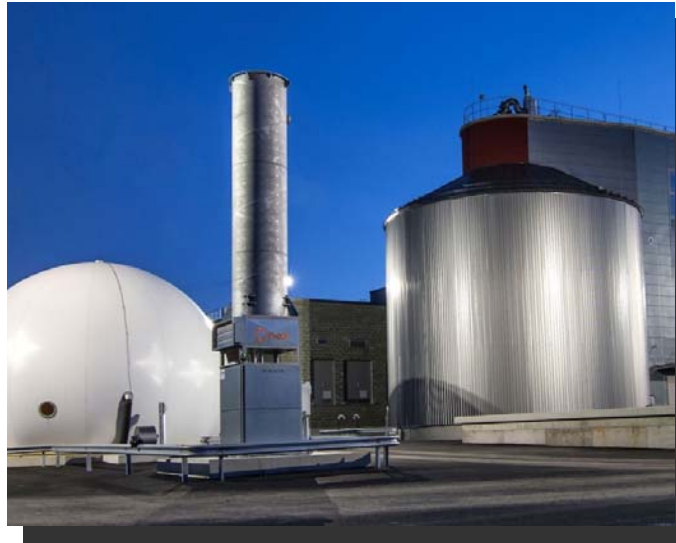
Betriebsfackel Typ HTV 2,8, Biogasanlage 400 Bm 3 /h, Kokkola / Finnland
