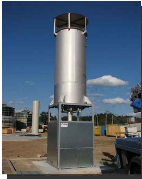
Notgasfackel Typ NTV 7,0 – Biogas 1.100 Bm 3 /h, Vilnius / Litauen
