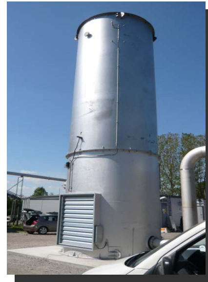
Hochtemperaturgasfackel Typ HTV 26 - Biogas 4.000 Bm 3 /h, Norrköping / Schweden
